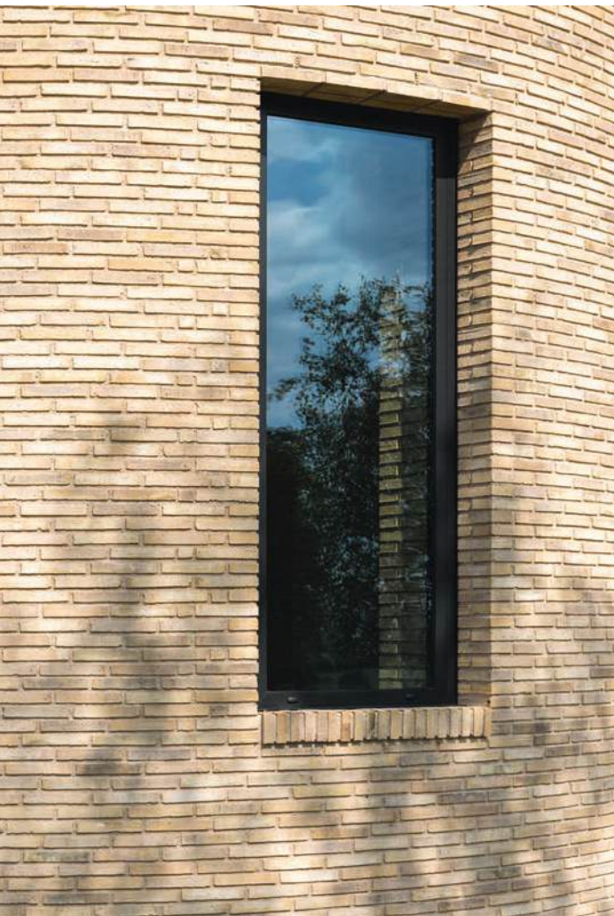
Die leicht unregelmäßige Struktur des wassergestrichenen D-Steins verleiht dem Mauerwerk ein lebendiges Aussehen.
