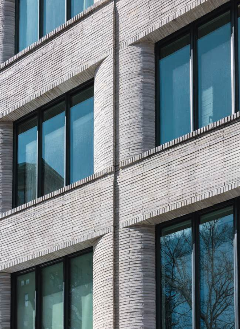
Die Fensterbänke und Stürze der Fensterfronten sind als Rollschichten ausgeführt. Foto: Dean Kaufman
