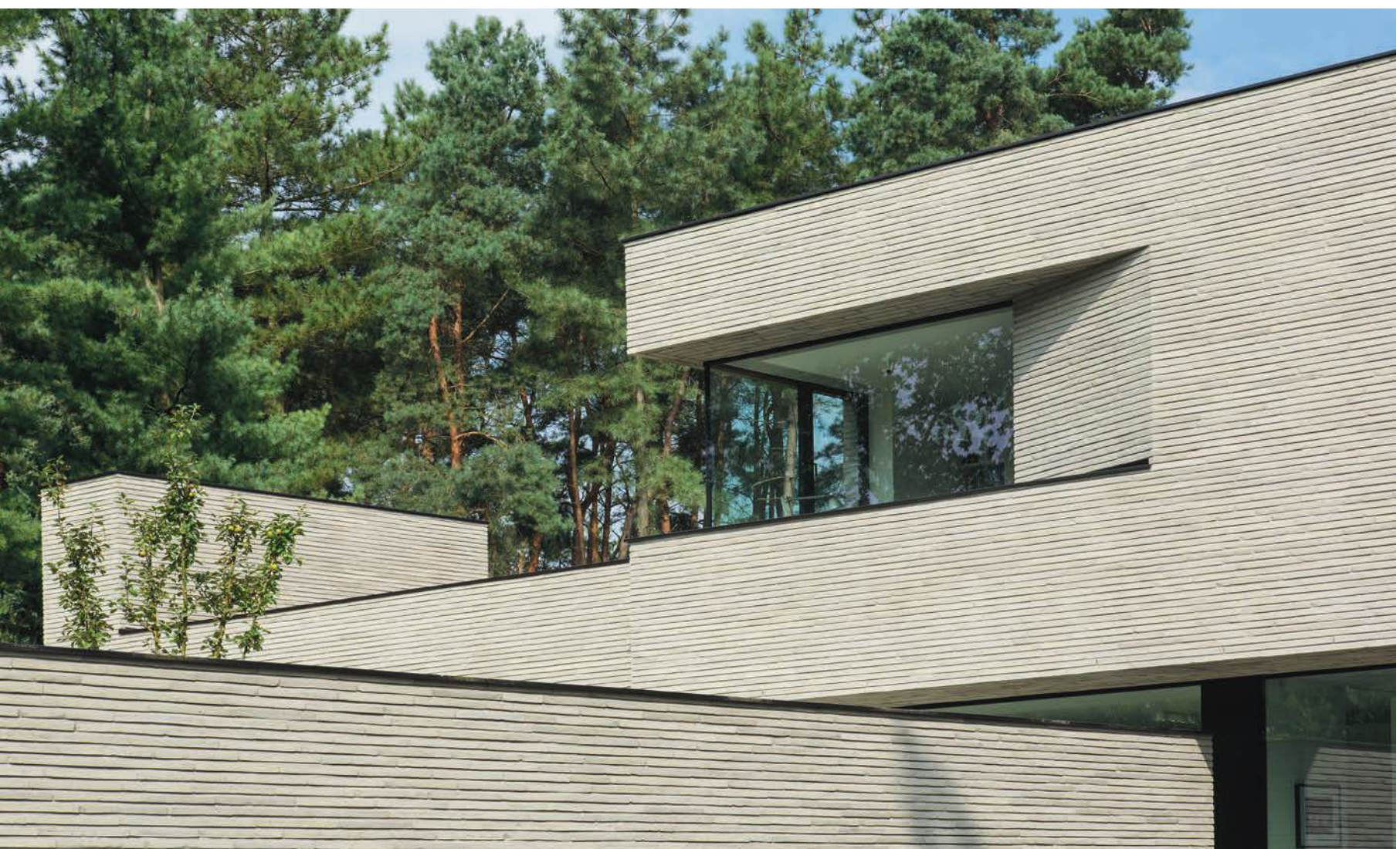
Die Fugenfarbe ist genau auf den Stein abgestimmt. Durch den wilden Verband mit gepressten Lagerfugen und Stoßfugen auf gleicher Ebene dominieren die horizontalen Linien das Erscheinungsbild des Mauerwerks.
