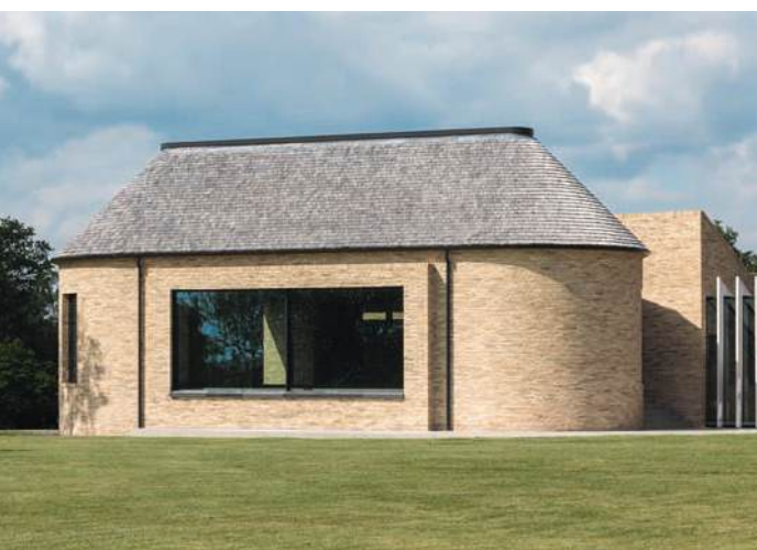
Der Radius des abgerundeten Gebäudes ist so groß, dass es ausschließlich mit Standardsteinen gemauert werden konnte.
