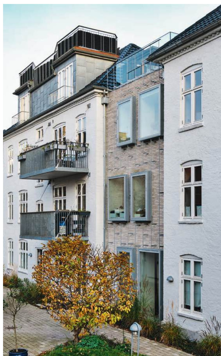
Die Fenster sind seitlich versetzt und leicht von der Fassadenflucht nach vorne gezogen, sodass sie im Inneren zu tiefen, erkerartigen Nischen werden.
