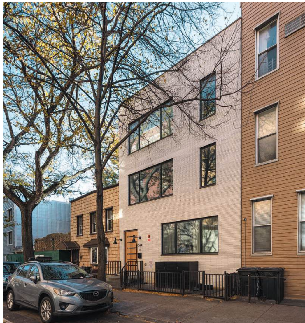
Im Rahmen des Umbaus des Gebäudes 264 North 6th Street wurde die Fassade mit K11 verkleidet, dessen helle Farbtöne sich harmonisch in das Straßenbild einfügen.
