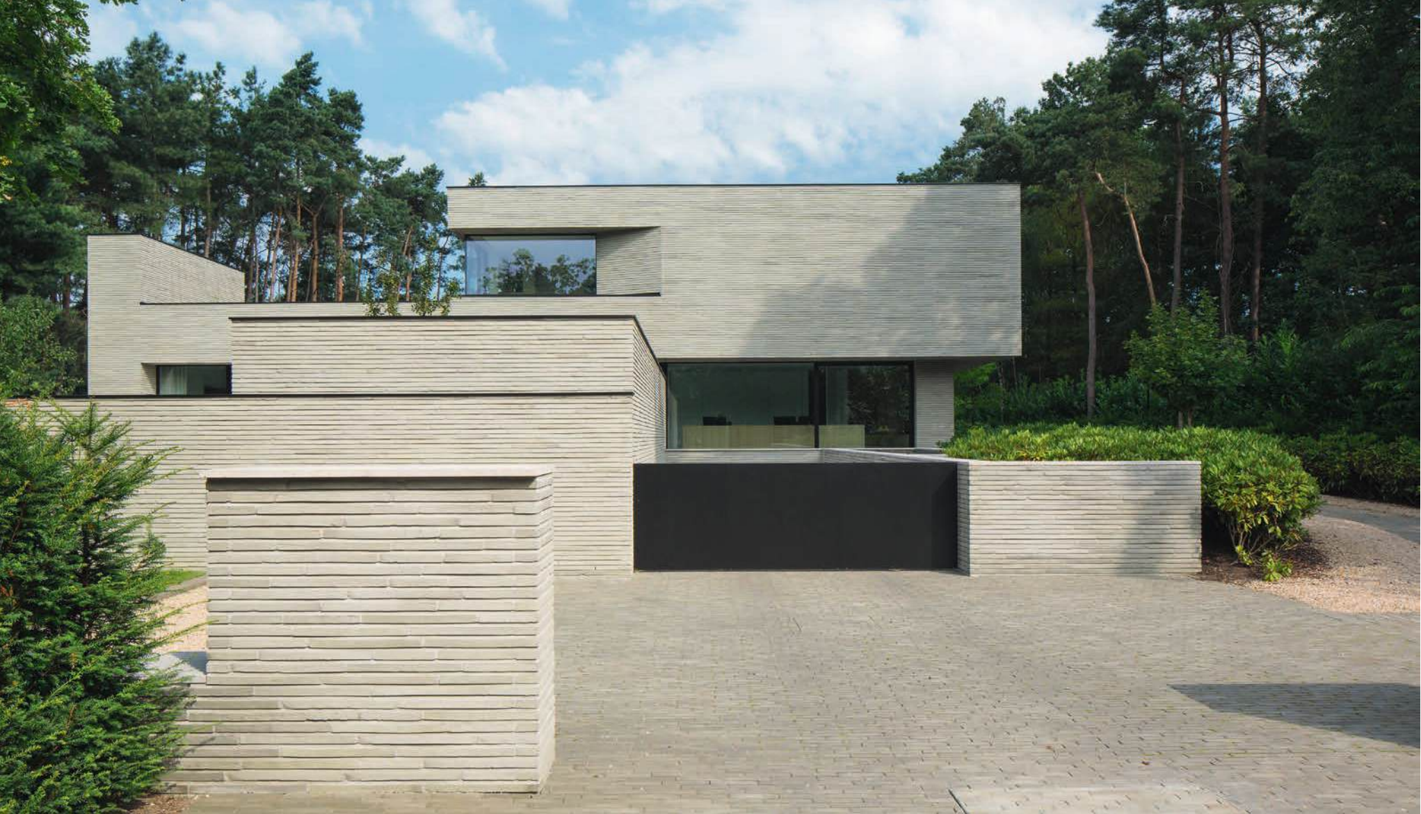
Die Hauptfassade zur Villenstraße hin wirkt wie eine Collage aus hellgrauen Mauerwerksflächen. Das Fehlen bekannter architektonischer Elemente wie Dachrinnen, Fallrohre oder Haustür verleiht dem Haus einen abstrakten Charakter. K21 wurde für die Fassade sowohl als Belag des Platzes vor dem Haus als auch des Wegs zur Haustür verwendet.
