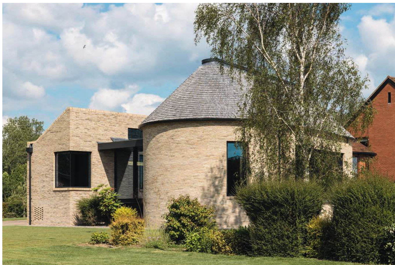
Das Poolhaus ist mit Kalkmörtel gemauert. Das Dach ist mit Schindeln aus Eiche gedeckt.
