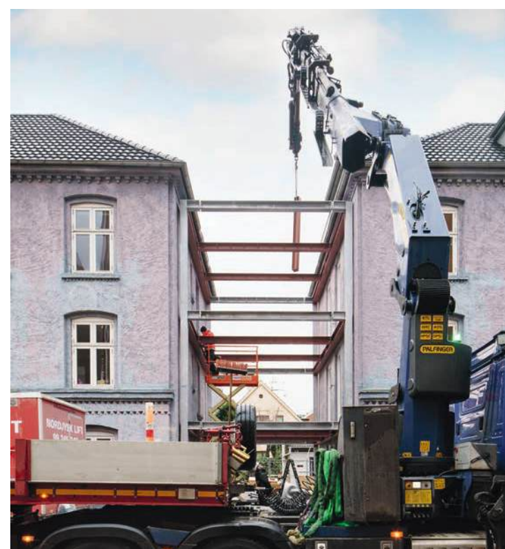
Eine Stahlrahmenkonstruktion aus recyceltem Stahl bildet die tragende Struktur des Anbaus. Foto: Morten Aagaard
