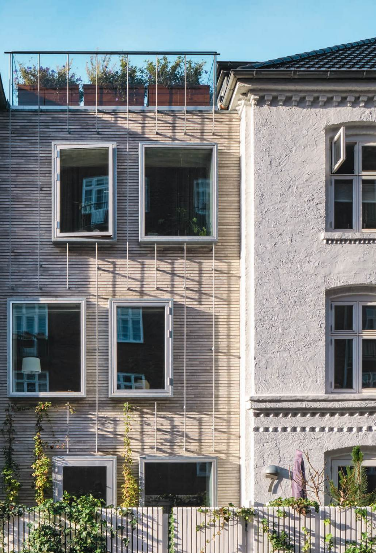
Die Fenster sind seitlich versetzt und leicht von der Fassadenflucht nach vorne gezogen, sodass sie im Inneren zu tiefen, erkerartigen Nischen werden.
