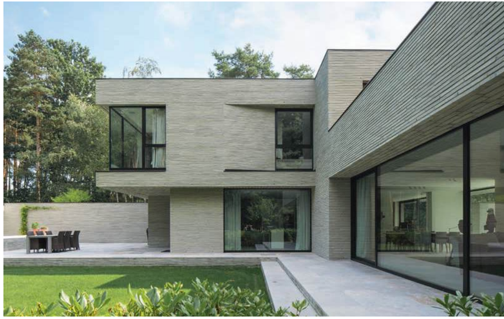
Die großen Terrassen vor dem Haus sind mit dem Naturstein Pietra dei Medici gepflastert. Die Fensterrahmen sind aus Kupfer gefertigt, das sich auch in den Fensterbänken und der Mauerkrone wiederfindet.
