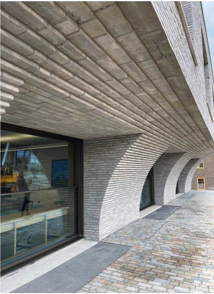
Das Brighton College liegt nur wenige hundert Meter vom Meer entfernt. Im rauen Küstenklima, wo Salz, Wind und Regen die Gebäude stark abnutzen, ist Ziegelstein ein geeignetes Material.
