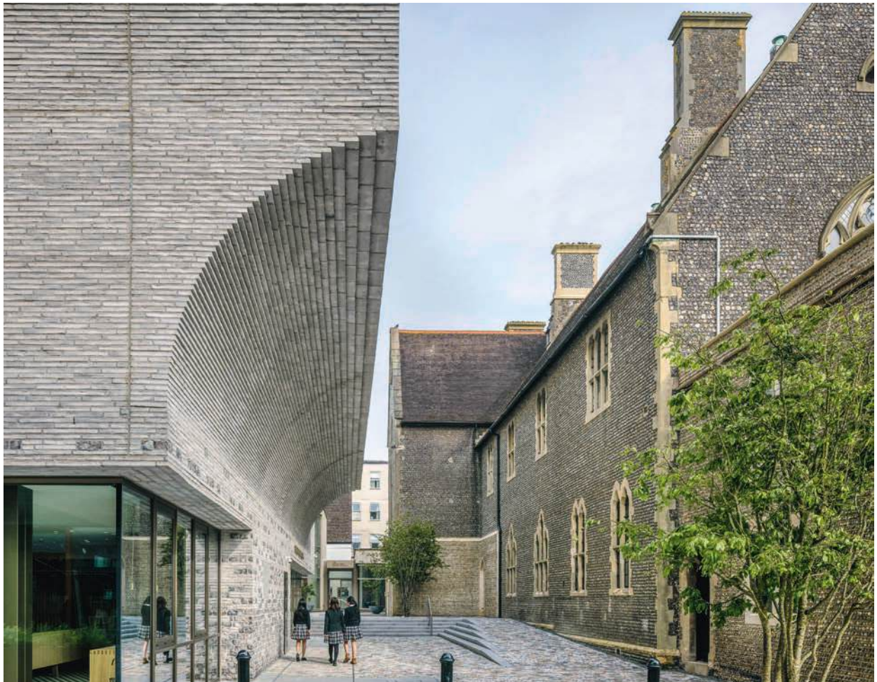
Der freitragende Bogen des Erdgeschosses ist in laufendem Verband aus Kolumba gebaut, wobei jeder Stein vom vorherigen leicht versetzt ist. Foto: Annette Petersen
