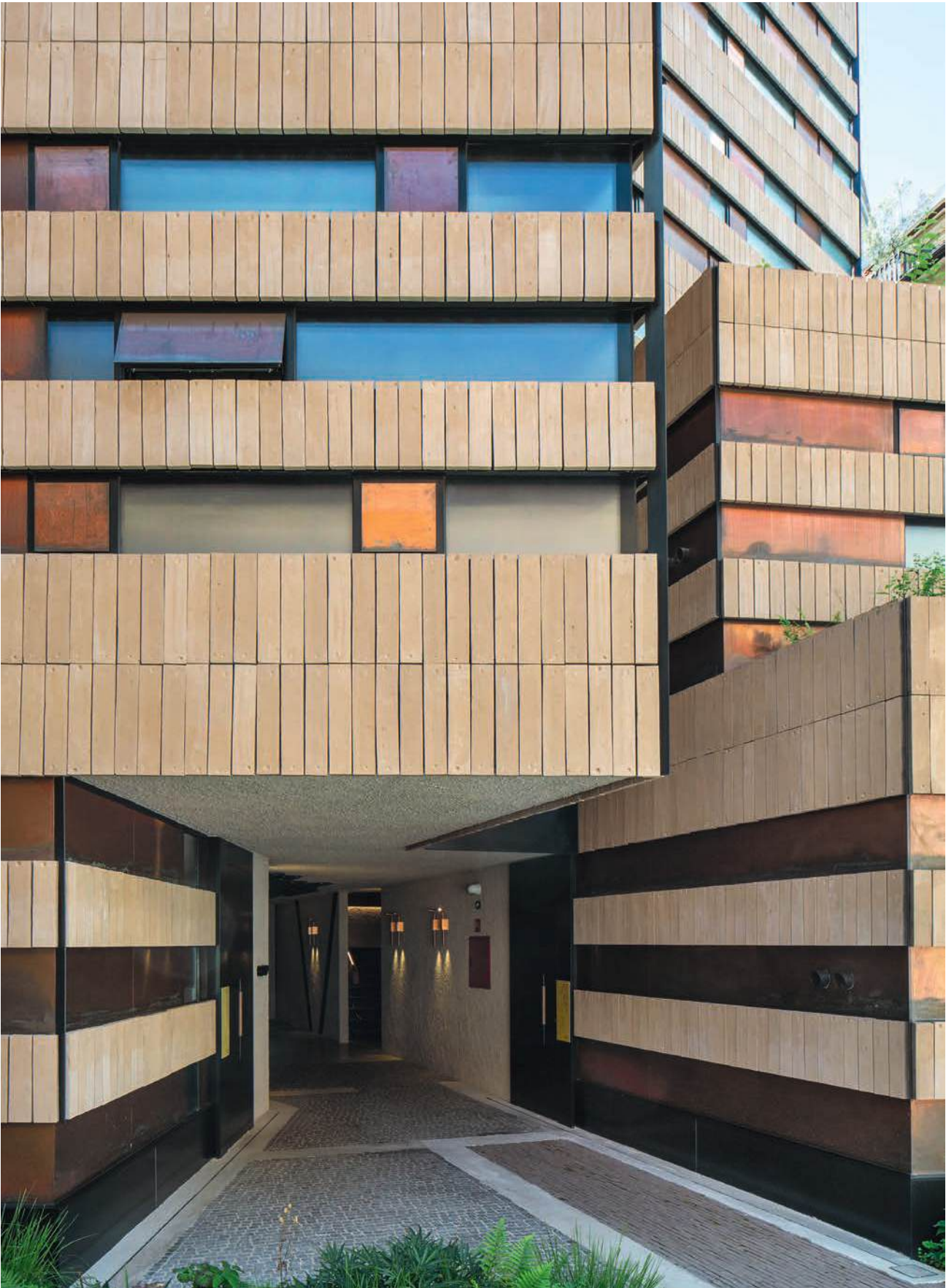
Die Kolumba-Steine sind an einer Stahlkonstruktion angebracht, die mit dem Betonkern des Gebäudes verbunden ist. Die Daumenabdrücke auf den handgefertigten Steinen erscheinen als kleine Ornamente.
