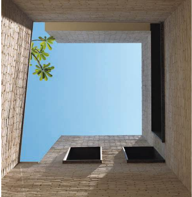
Ein Lichtschacht im nördlichen Flügel des Hauses bringt Licht in die Wohnräume zu beiden Seiten des Schachtes.
