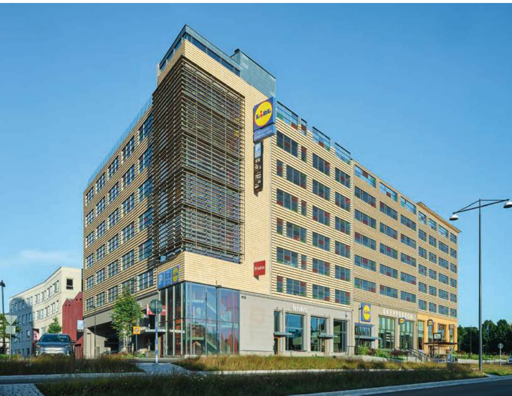
Zur Straße ist die Fassade in vier Einheiten unterteilt, die je einen leicht unterschiedlichen Ausdruck haben. Unter anderem werden unterschiedliche Cover-Formate für die Einheiten verwendet, in denen das Parkhaus untergebracht ist.
