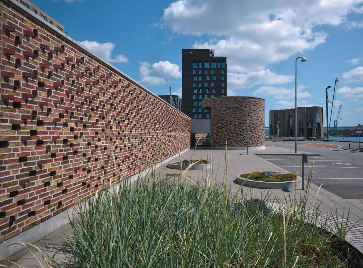
Vom 120 Meter langen Parkplatz aus kann man den Fjord im Osten überblicken. Das Fjordenhus, rechts im Bild, erhebt sich 200 Meter weiter draußen über dem Wasser.
