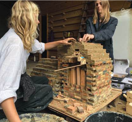
Der Massenofen ist aus Juniorsteinen gebaut, die 76 x 36 x 18 mm messen (1/3 des DNF-Formats)
