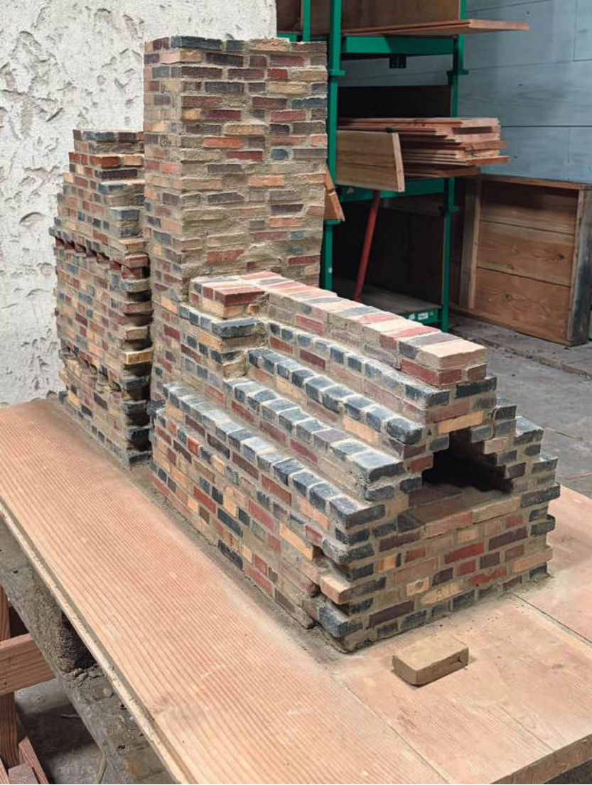
Der Massenofen ist aus Juniorsteinen gebaut, die 76 x 36 x 18 mm messen (1/3 des DNF-Formats)
