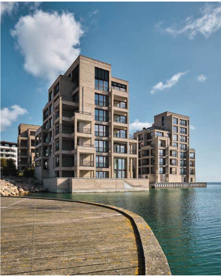
Die Wahl der Materialien für das Gebäude von Tuborg Strandeng ist von den Farbtönen inspiriert, die in der Umgebung der Svanemølle-Bucht zu finden sind. Die gelben Ziegelsteine sind auch eine Hommage an die alte dänische Industriekultur und das Erbe der Tuborg-Brauerei, die hier ab 1873 rund 100 Jahre lang Bier braute.
