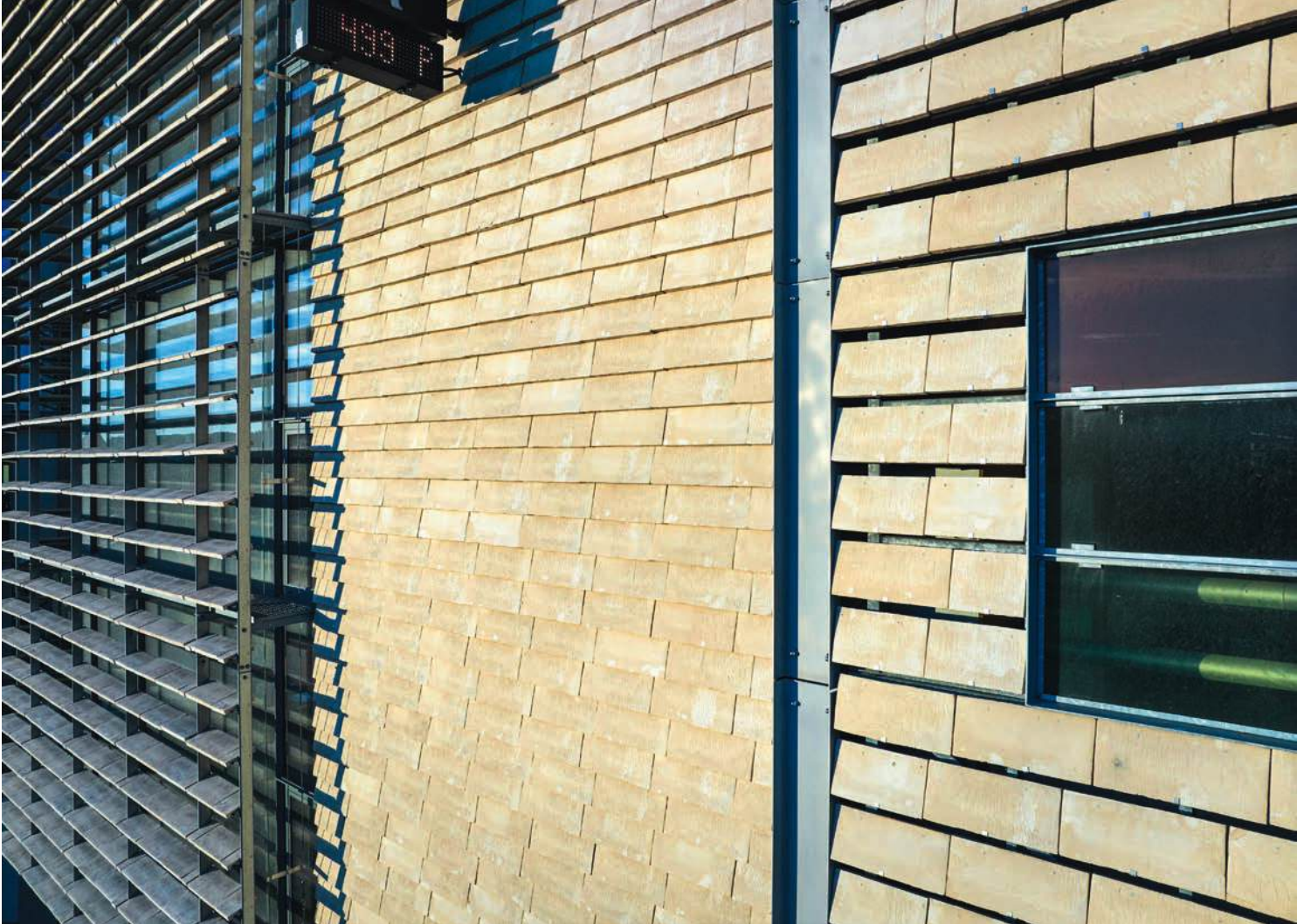
Bei dem Parkhaus in Jönköping wird Cover als Sonnenschutz verwendet, der traditionell als Gebäudehülle befestigt und zur Belüftung des Gebäudes in einem gewissen Abstand installiert wird.
