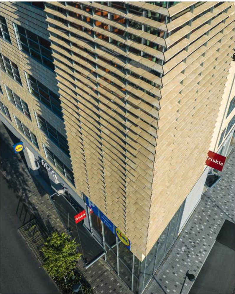
Am Turmhaus des Gebäudes dient der handgefertigte Stein als Sonnenschutz und erzeugt ein Spiel aus Licht und Schatten auf der Fassade.
