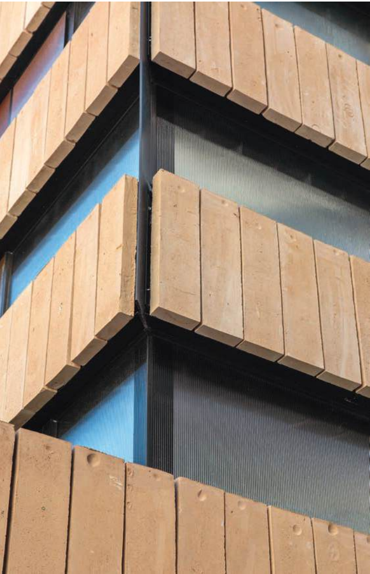
Die Kolumba-Steine sind an einer Stahlkonstruktion angebracht, die mit dem Betonkern des Gebäudes verbunden ist. Die Daumenabdrücke auf den handgefertigten Steinen erscheinen als kleine Ornamente.
