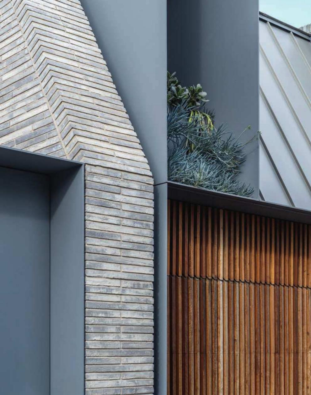
Das Mauerwerk der Wände ist im Blockverband gemauert, wobei jede zweite Schicht aus einem Stein in voller Länge, d. h. 529 mm, besteht.
