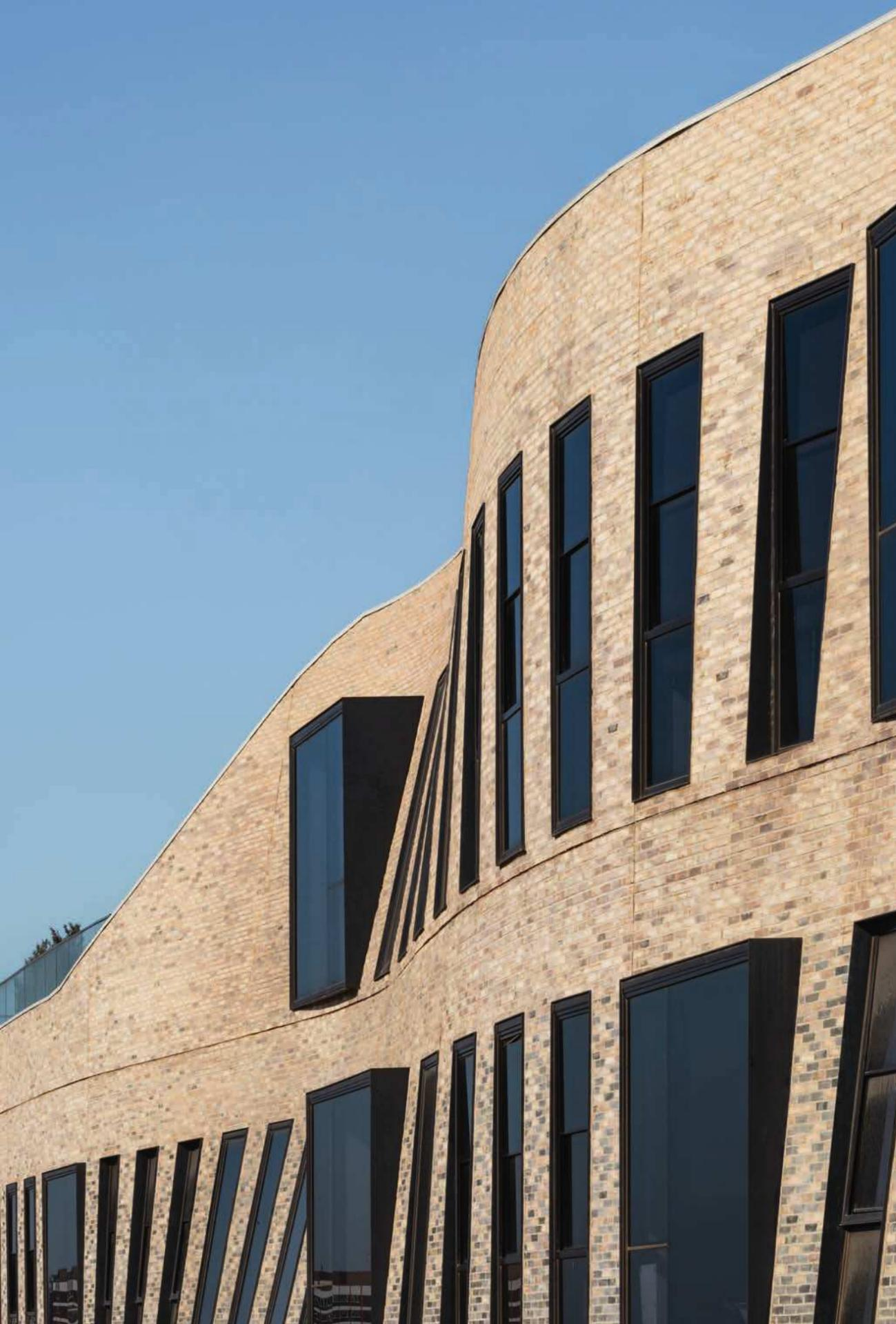
Die doppelt gekrümmten Fassaden waren eine technische Herausforderung, die dank einer darunter liegenden Stahlkonstruktion gemeistert werden konnte. Das wellenförmige Mauerwerk ist farblich von weißlich und blassgelb bis hellgrau und dunkelgrau abgestuft.
