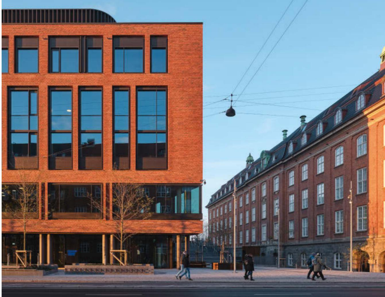
In den beiden unteren Stockwerken der beiden Gebäude löst sich die Fassade in große Glasflächen auf. Nur wenige Stützen reichen in Form von gemauerten Pfeilern bis zum Boden, andere werden zu runden Betonsäulenpaaren. Die roten Ziegel finden sich auch im Postgebäude von 1914 wieder, dem heutigen Hotel Villa Copenhagen, rechts im Bild.
