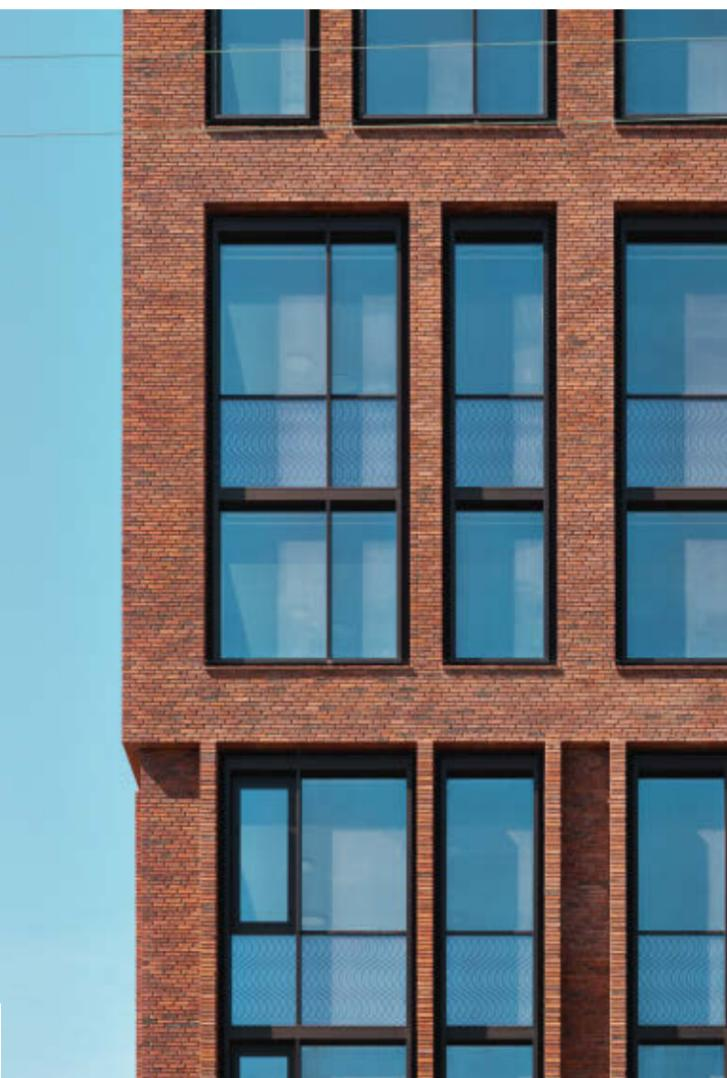
Die gesamte Fassade ist mit roten Ziegeln verkleidet, einschließlich der horizontalen Brüstungsbänder, der vertikalen Pfeiler im Abstand von 6 Metern und der sekundären vertikalen Pfosten. Die Hauptproportionierung wird durch ein Rahmenmotiv aus dunkelbraunem, anodisiertem Aluminium, das jeweils bis zu drei Stockwerke überspannt, weiter unterteilt.
