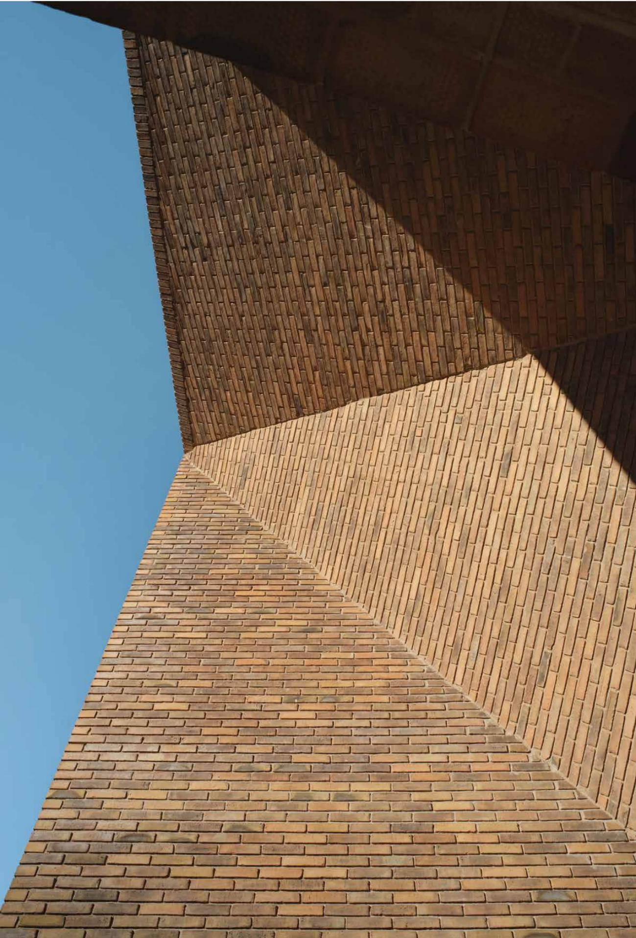
Das Portal wurde mit den gleichen Ziegel verkleidet wie das übrige Gebäude. Piercy&Company haben sich beim Mauerwerk für den ruhigen Läuferverband entschieden.
