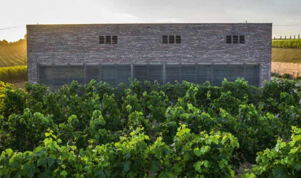
Der Sonnenschutz aus Lamellen in Holz an der gesamten Ostfassade kann je nach Bedarf die Sonne fast vollständig abhalten oder auf der Terrasse Schatten spenden.
