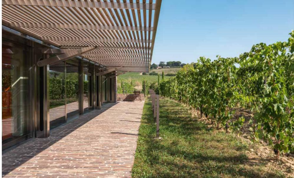
Bodentiefe Fenster schaffen eine Verbindung zwischen dem Außen- und dem Innenbereich des öffentlichen Gebäudeteils. Auch der Boden vor dem Gebäude wurde mit Kolumba-Ziegeln verkleidet.
