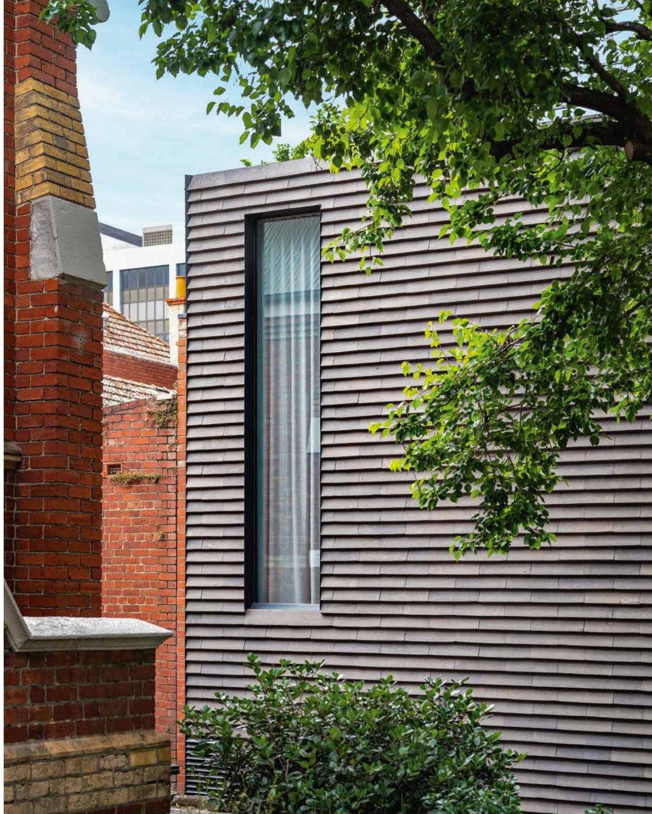
Der von Hand gefertigte Cover-stein sorgt für subtile Variationen an der Fassade. Im Lauf des Tages unterstreicht die Verlegung die Veränderungen des Sonnenlichts.
