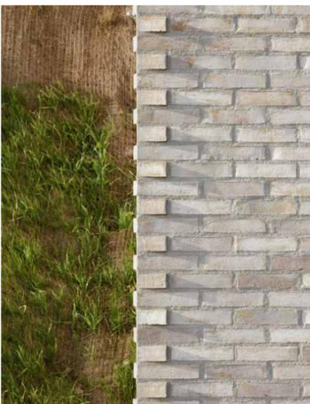
Die Ecken des Stationsgebäudes haben keine 90 Grad, weshalb die rechteckigen Steine überstehen und ein spannendes Muster bilden. Das Mauerwerk wurde im Halbsteinverband errichtet.
