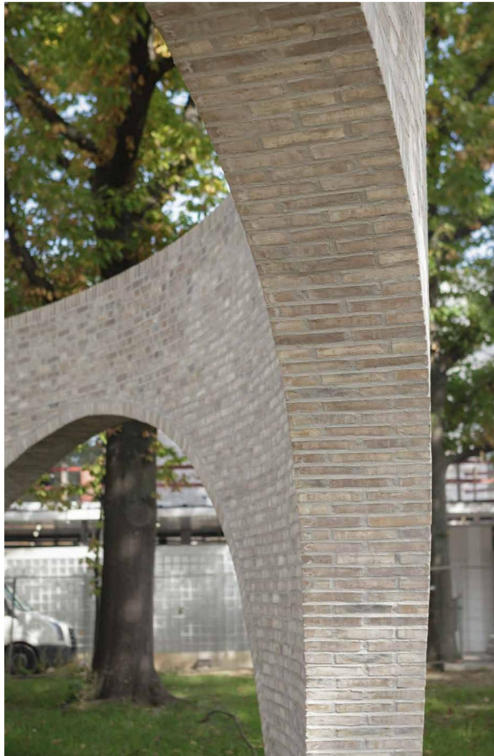
Das Sichtmauerwerk wurde in einem Mauerwerksverband errichtet, der aus zwei Läufern und einem Kopf besteht und bei dem die Köpfe in jeder zweiten Reihe übereinander platziert sind.
