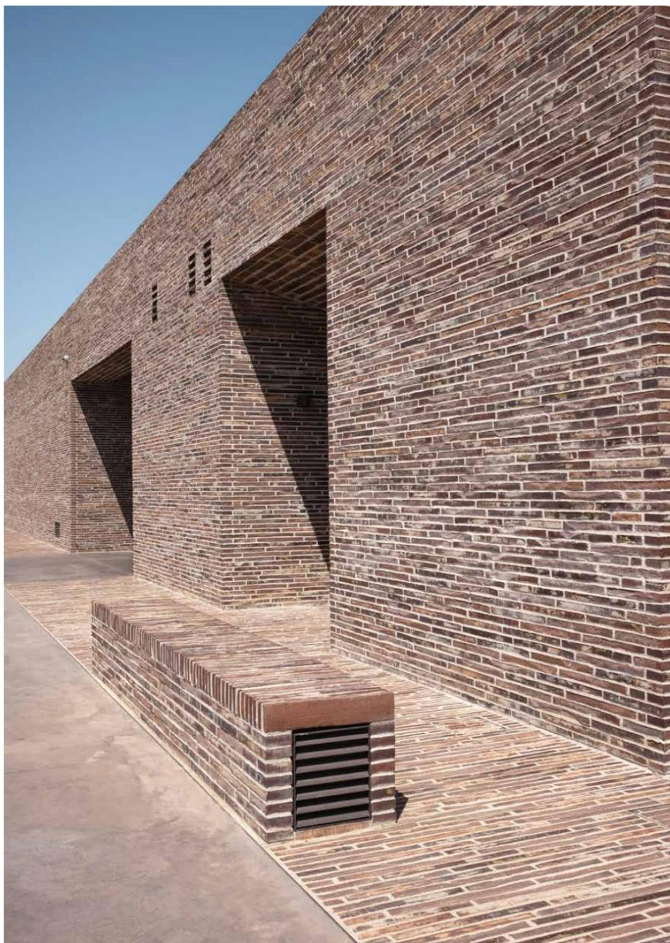
Das Belüftungssystem des Weinkellers wurde in die gemauerten Außenbänke integriert. Die Tiefe der Bänke entspricht genau der Länge eines Kolumba-Steins.
