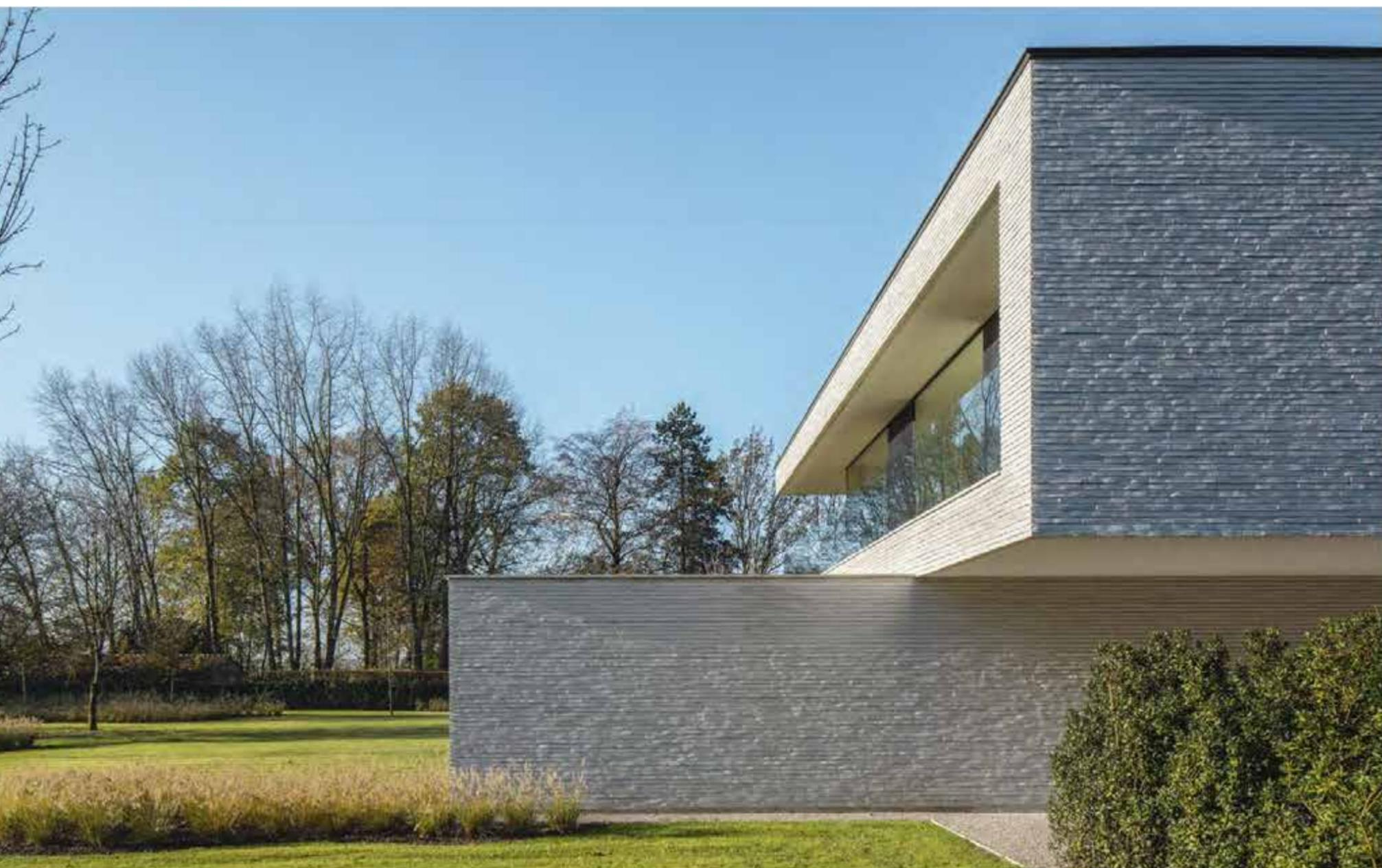
Architekt Geert Berkein bevorzugte eine einheitliche Mauerfläche und entschied sich daher für eine Fuge in der Farbe der Ziegel. Die Fuge wurde leicht eingezogen, wodurch eine diskrete Reliefwirkung entstand.
