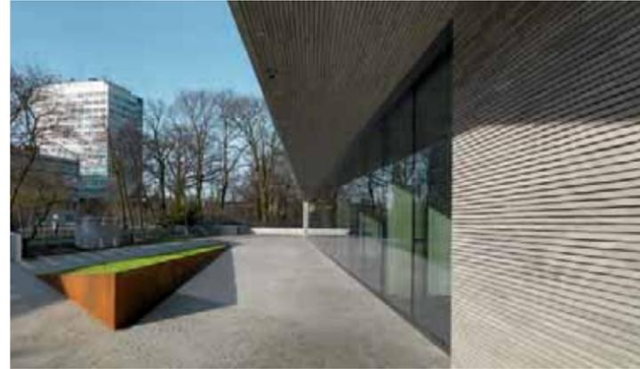
Nach Süden hin wurde das Erdgeschoss zurückversetzt. Die Unterseite des ausgekragten ersten Obergeschosses wurde, genau wie die Fassade, mit Kolumba verblendet. Foto: Wojciech Krynski.
