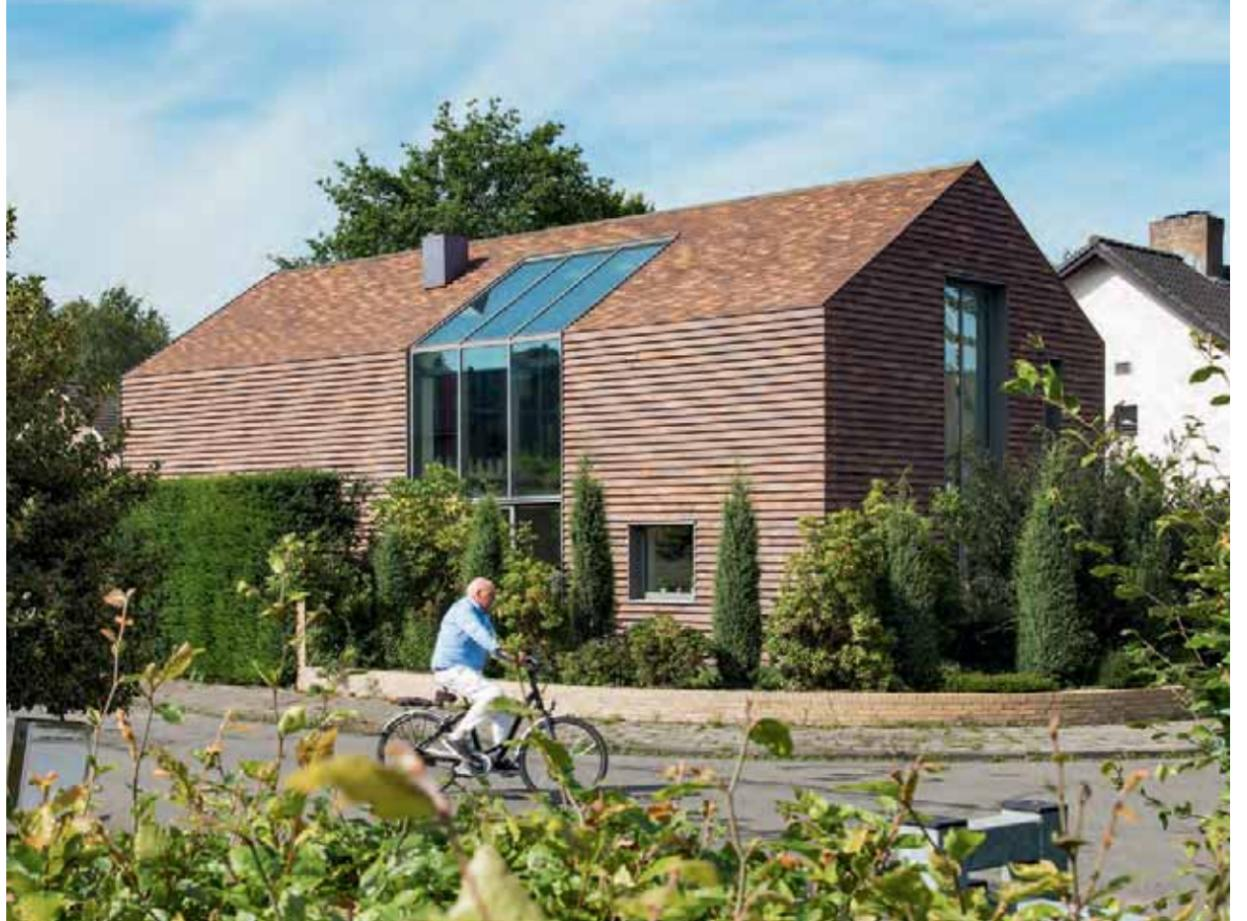
Der Architekt wollte die Ziegelverkleidung durchbrechen und plante die Fassade nach Osten mit einer großflächigen Glaspattie, die in die Dachfläche übergreift.
