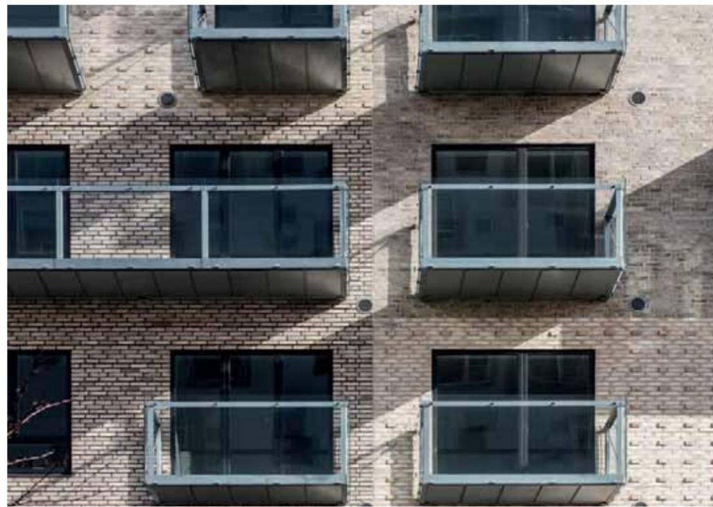
Die Ziegel sind die gleichen, aber ihr Ausdruck variiert beträchtlich wegen der unterschiedlichen Mauerverbände und der Fugenfarben und auch dadurch, dass die Binder Vorsprünge in der Fassade bilden.
