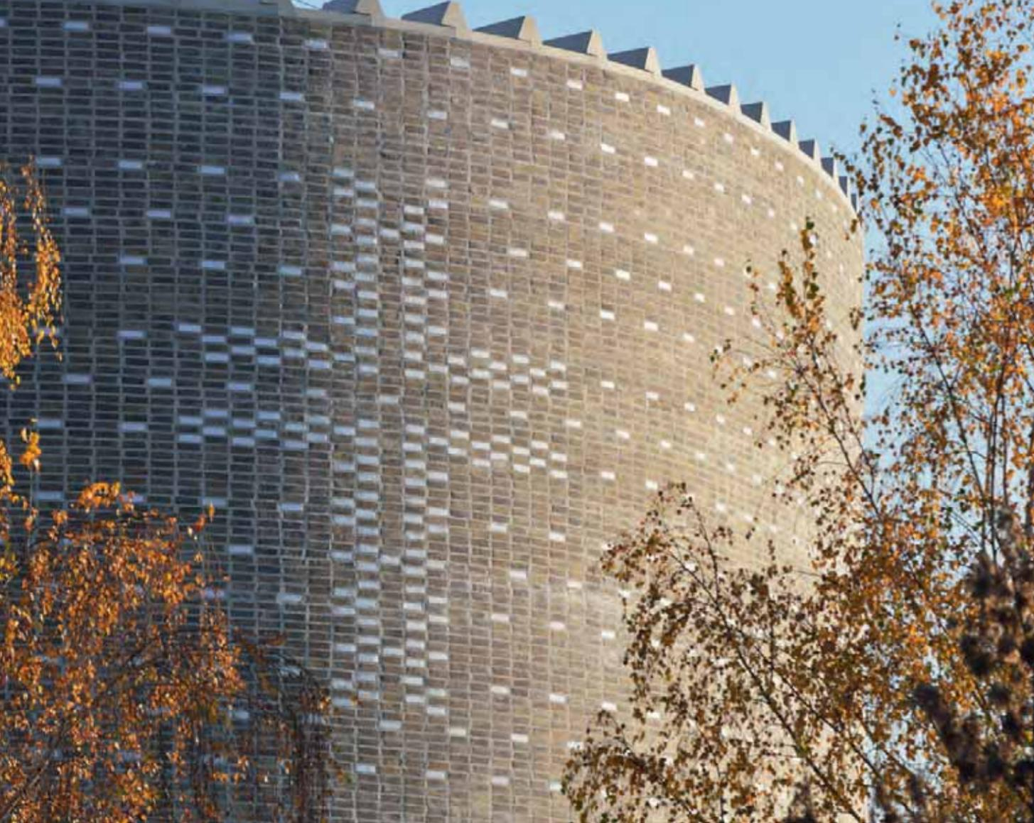
In die gerundete, mit goldenen Kohlebrandziegeln verkleidete Fassade wurde ein Muster aus weißen, glasierten Ziegeln eingelassen. An einigen Stellen sind die Steine so platziert, dass sie sieben Kreuze bilden.
