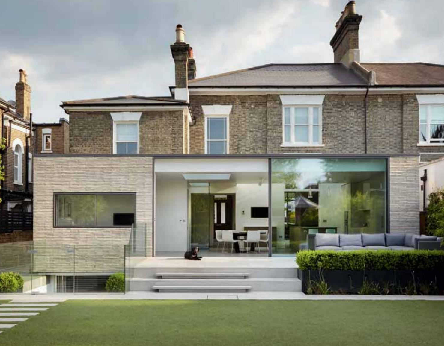
Der elegante eingeschossige Anbau nimmt die gesamte Breite des älteren Hausteils ein. Die Hälfte der Glasfront lässt sich zur Seite schieben, so dass eine offene Verbindung zur großen Terrasse entsteht.
