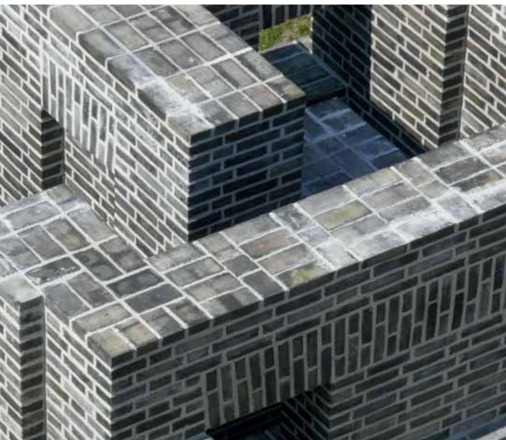
*Der Abschluss oben erfolgt mittels Quartiersteinen in der Vormauer. Dadurch kann nach oben und zur Mitte versetzt gemauert werden. Die Mauer wird ohne andere Stützen als einige zusätzliche Mauersteine geschlossen werden.*
