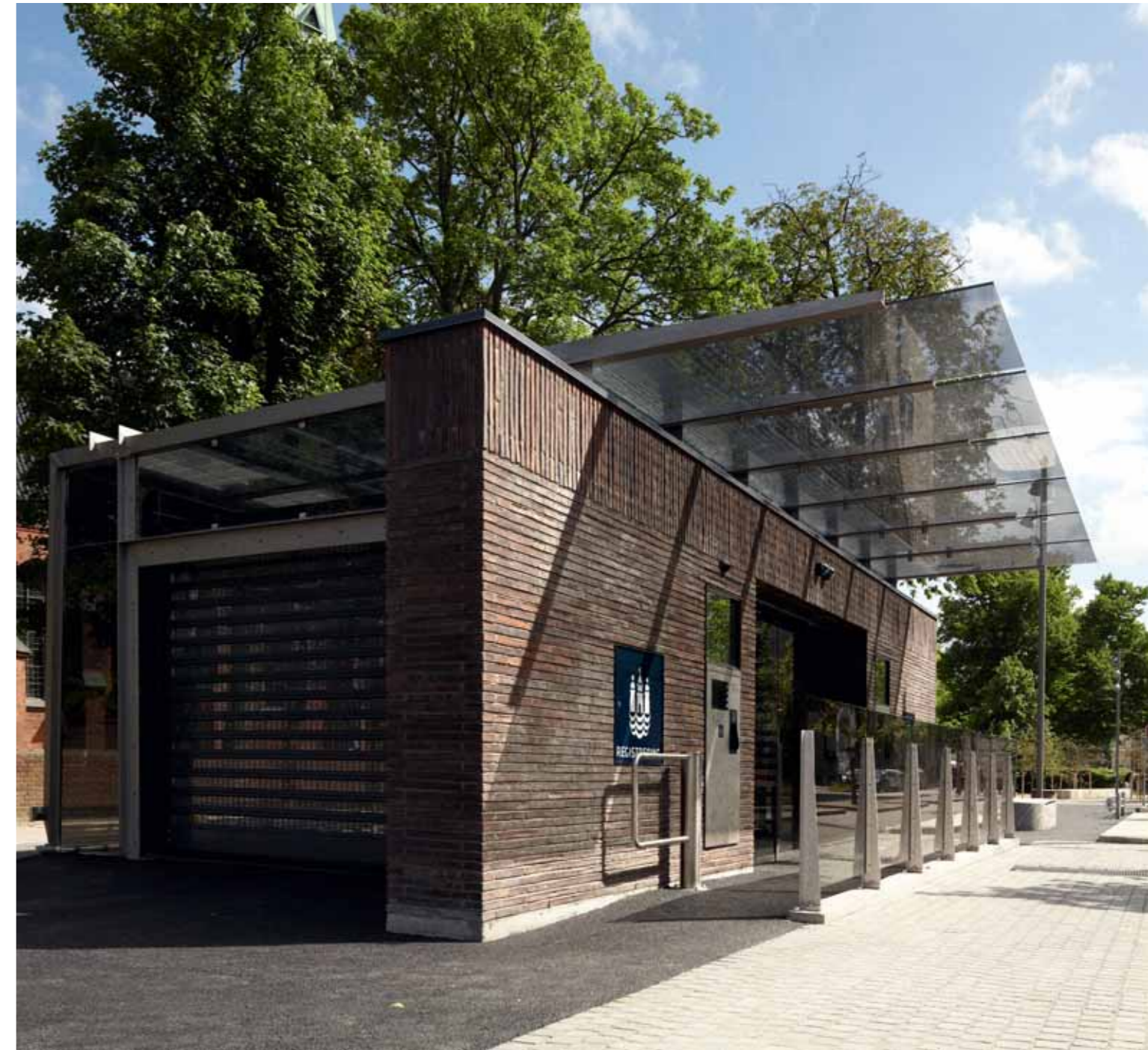
Die Aufzugboxen für die neue Autoparkanlage ist aus dem Kolumba-Stein errichtet. Das lange, flache Format des Steins hebt die Längsrichtung der Mauer hervor und trägt gleichzeitig zur Designqualität der Aufzugbox bei.
