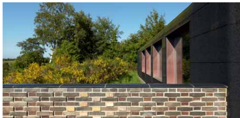
Das Haus hat keine Dachrinne, um die gerundete Form zu unterstreichen. Die mit Kupfer verkleideten Fensternischen sitzen daher tief, um die Fenster gegen Regen zu schützen.
