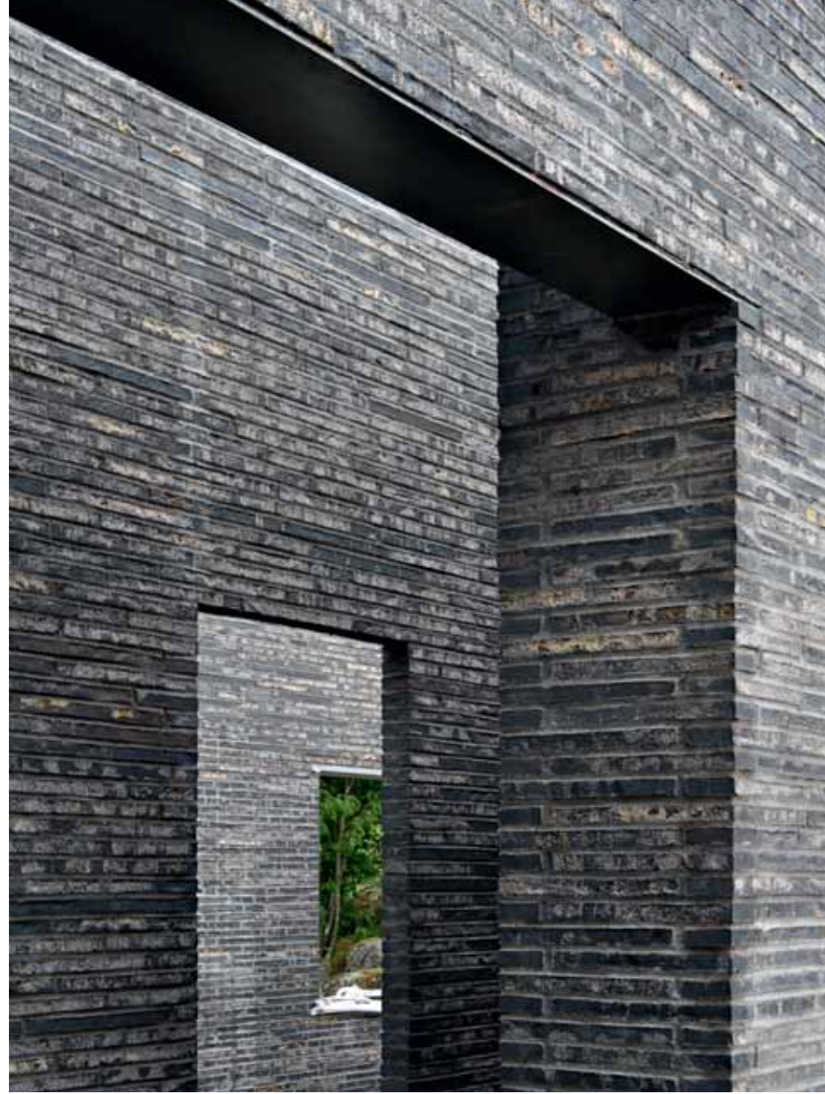
Die Kirche von Bøler, die 2011 fertig sein wird, erhält eine schwere Basis aus dem Kolumba-Stein K58.
