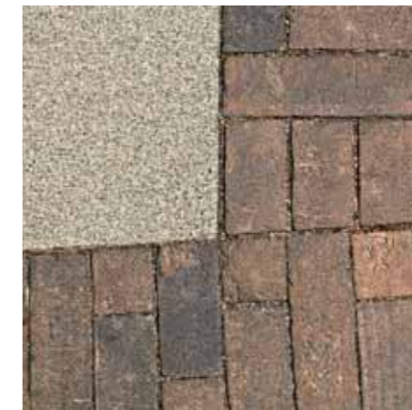
Der neue Klinker hat das Format 300x97x65 mm, bei dem die Maße des Binders in der Seitenlänge aufgehen. Daher konnten die vielen Übergänge im Belag fast ohne Schneiden der Steine durchgeführt werden.
