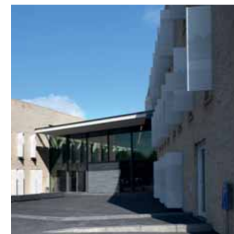
Man kommt aus Südosten zwischen den beiden Flügeln in das Rathaus. Von hier wird man in den zentralen Verteilungsraum geleitet.
