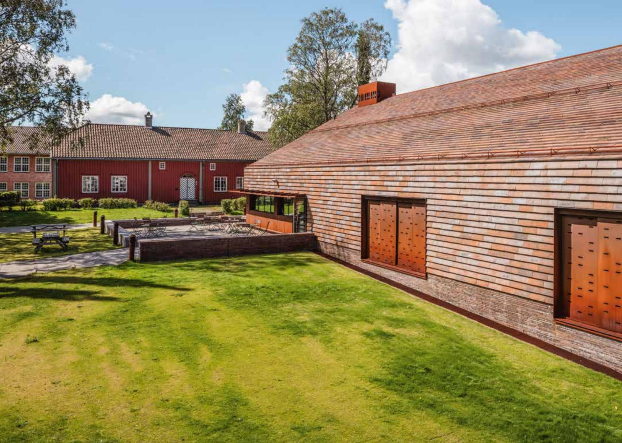
Das umgebende Gelände hat ein Gefälle von 1,7 Meter von Südosten nach Nordwesten. Der Niveauunterschied wird von einem direkt auf der Erde gemauerten Sockel aus Kolumba ausgeglichen. Alle Bauelemente wurden aus Cortenstahl gefertigt, auch die zurückgezogenen Fensterpartien. Mit zwei Reihen perforierter Schotten lassen sich je nach Bedarf Licht oder Dunkelheit in den Ausstellungsräumen regulieren.
