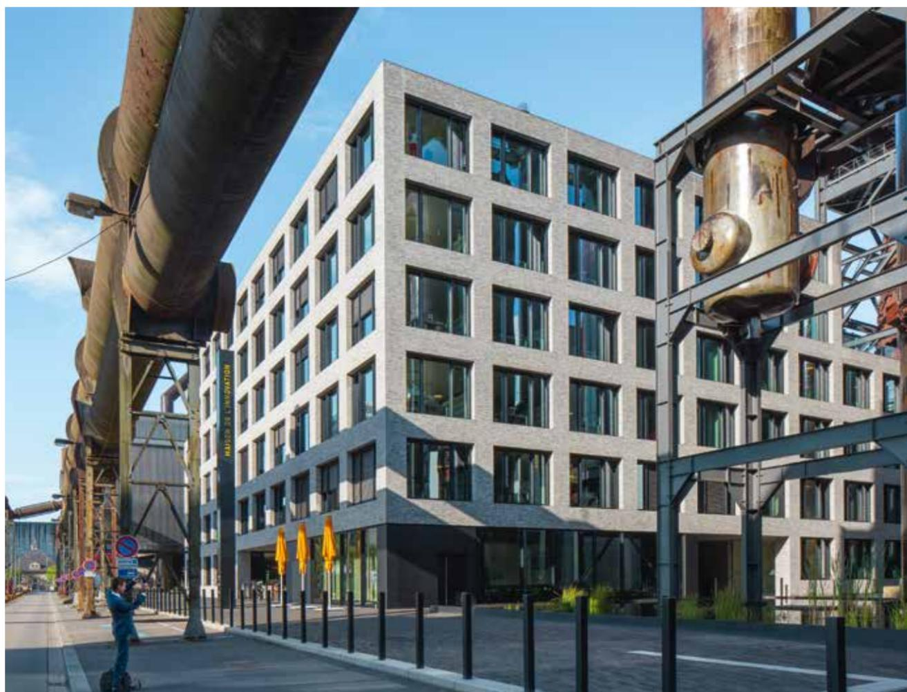
*Das Gebäudevolumen wurde als Gegenstück zu den erhaltenen Teilen des Eisenwerks konzipiert. Die Fassaden aus grauen Ziegeln und ein grauer Mörtel tragen ebenfalls dazu bei, dem Gebäude Homogenität zu verleihen. Um die Textur zu unterstreichen, wurden die Ziegel im wilden Verband vermauert.*
