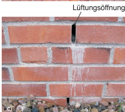
Entwässerungsöffnung
