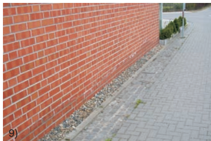
Bild 8. Stand der Baupraxis in Norddeutschland: Verblendmauerwerk wird ins Erdreich geführt, ohne eine Entwässerung unterhalb der Geländeoberfläche vorzusehen
