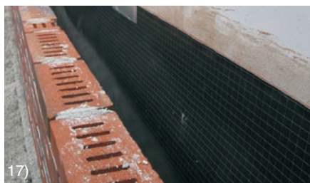
Bilder 17 und 18. Durch eine fachgerechte Abdichtung des Sockels vor Beginn der Mauerarbeiten der Verblendschale ist dafür gesorgt, dass die Innenschale dauerhaft vor Einwirkung des Regenwassers geschützt ist. Die Sperrbahnen werden an der tragenden Wand so befestigt, dass sie in ihrer Lage dauerhaft funktionsfähig bleiben (durch punktuelle Befestigung oder Verklebung)
