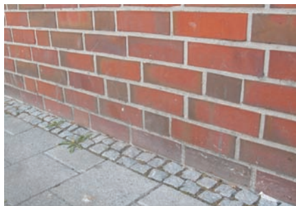
Bild 8. Stand der Baupraxis in Norddeutschland: Verblendmauerwerk wird ins Erdreich geführt, ohne eine Entwässerung unterhalb der Geländeoberfläche vorzusehen
