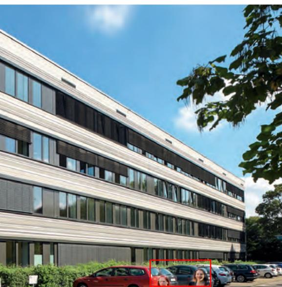
Die energetische Fassadensanierung des Hauptschulgebäudes des Erich-Gutenberg-Berufskollegs in Köln-Buchheim verfolgte nicht nur das Ziel des Energiesparens. Auch die Außenwirkung des Stahlbetonskelettbbaus mit Waschbetonfassade aus den 60er Jahren sollte aufgewertet werden. Architekt Seyed Mohammad Oreyzi wollte für eine würdevolle Einrichtung wie eine Schule ein entsprechendes
