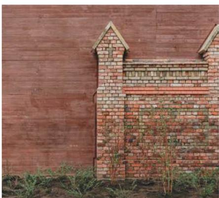
Auf der nördlichen Stirnseite wird der Abschluss der denkmalgeschützten Friedhofsmauer wie eine Intarsie in die Sichtbetonfassade integriert. Ein umlaufendes Fassadenband aus
