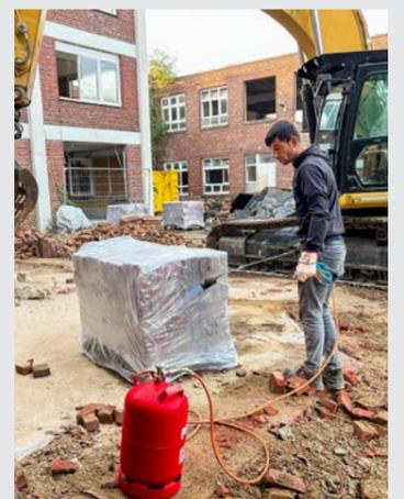
Nach einem möglichst behutsamen Abriss der Bestandsbauten werden die Abbruchziegel sorgfältig von Hand gesäubert, gestapelt und gut verpackt.
