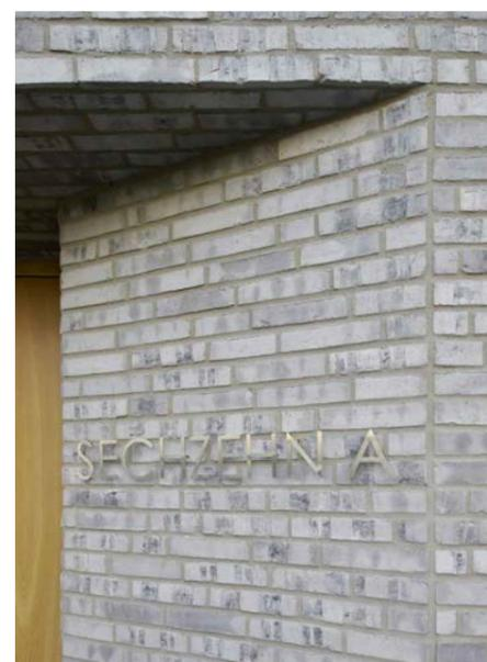
sind als Fußvermauerung ausgeführt. Dabei wird die Rückseite (Fußseite) der Klinker als Sichtseite vermauert. So entsteht eine ausdrucksstarke Ober-
