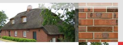
Perfekte Dämmung, alter Charme: behutsame Sanierung mit Wärmedämmverbundsystem und Fassadenriemchen
