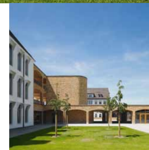
Im Bibliothekshof nördlich des Bestandsgebäudes liegt der Raum der Stille. Er dient als Ort der Andacht und Besinnung für alle Einrichtungen.
